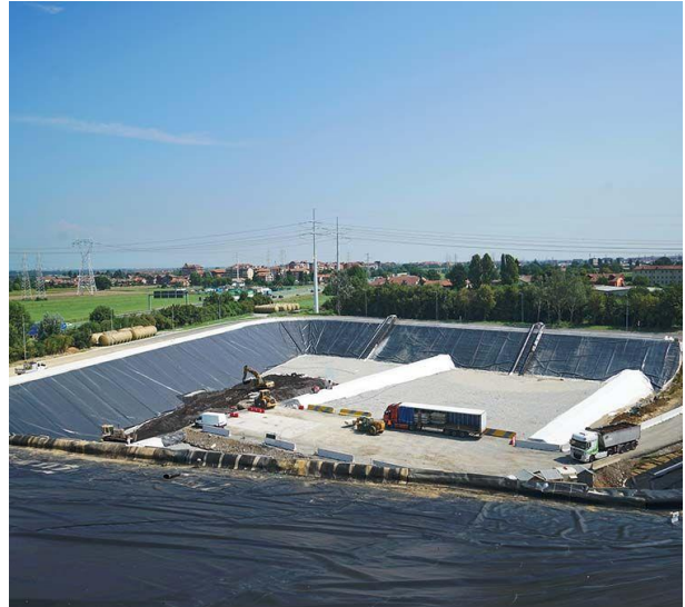
Preparazione di una cava di ghiaia per una discarica controllata di rifiuti solidi
