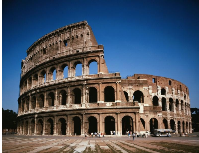
Il Colosseo: costruito con travertino, calcare, cemento, mattoni.
