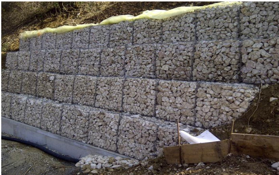
Gabbionate per argini con riempimento di ciottoli di calcari
