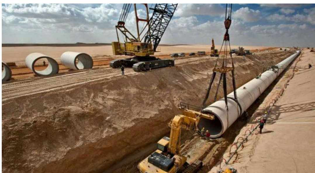
Costruzione del Great Man-Made River Project Libico
