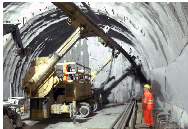
Lavori di sostegno e armature in galleria
