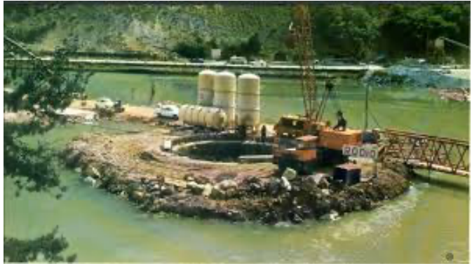
Impianto di congelamento sottopasso lago di Fortezza
