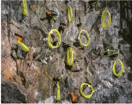
Fori da mina predisposti per la volata
