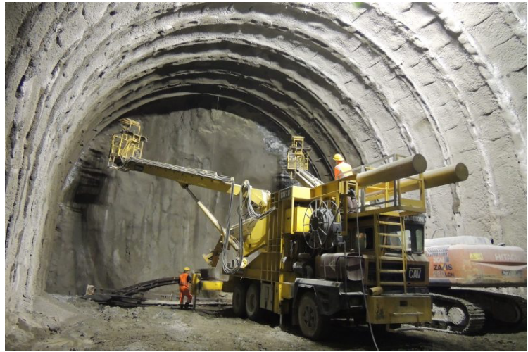
Chiodature e armature in rocce franose
