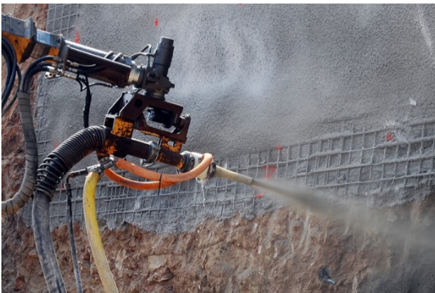
Posa di gunite armata (spritz beton)
