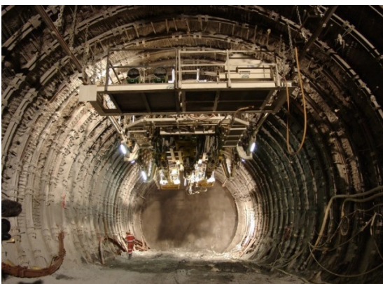
Perforatrici per i fori da mina sul fronte di scavo
