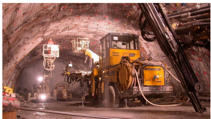
Perforatrici per i fori da mina sul fronte di scavo
