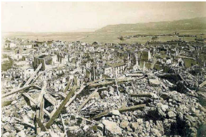
Terremoto di Messina del 1908
