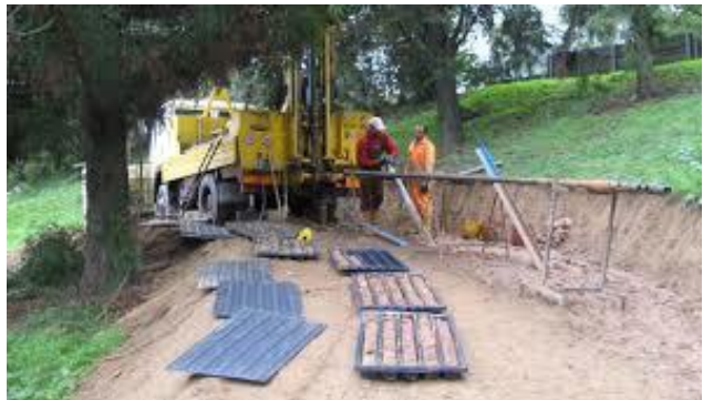
Carote di sondaggio nelle cassette portacampioni
