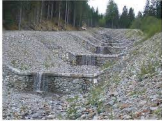
Traverse e briglie per la regimazione dei torrenti. Rallentano il trasporto solido a valle.
