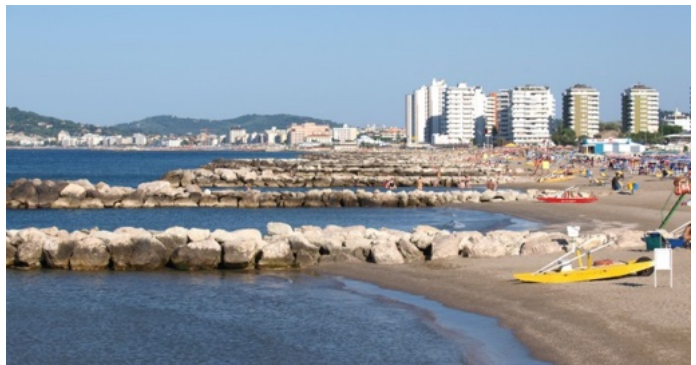
Scogliere e murazzi per contrastare l'erosione delle spiagge
