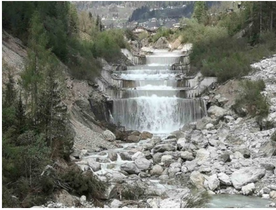
Traverse e briglie per la regimazione dei torrenti. Rallentano il trasporto solido a valle.
