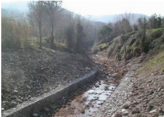
Protezioni di sponda di torrenti montani. Limitano l'erosione delle scarpate e rallentano il trasporto solido
