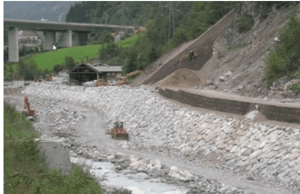
Protezioni di sponda di torrenti montani. Limitano l'erosione delle scarpate e rallentano il trasporto solido
