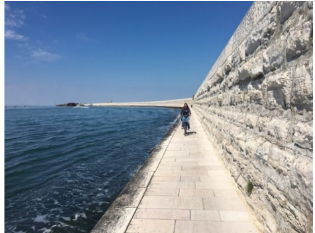
Scogliere e murazzi per contrastare l'erosione delle spiagge
