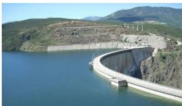
Dighe idroelettriche. Fermano il trasporto di materiali sciolti dei corsi d'acqua del bacino sotteso
