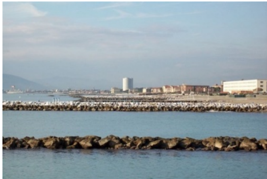
Scogliere e murazzi per contrastare l'erosione delle spiagge
