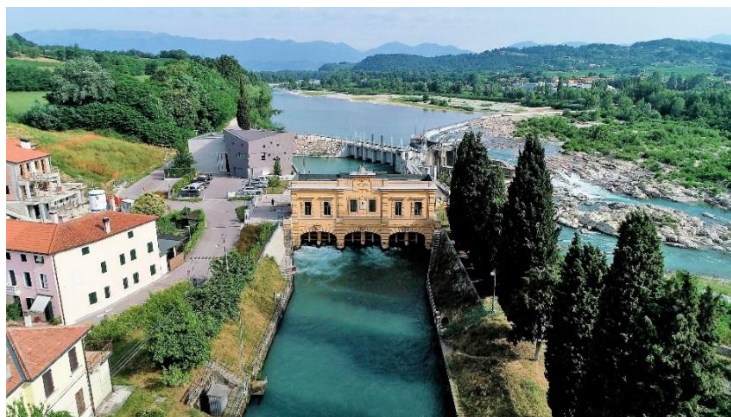
Derivazione irrigua e industriale dal Piave
